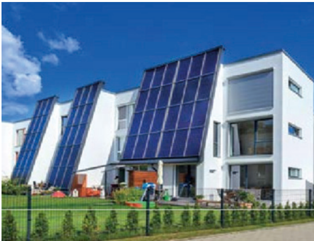
شکل ۵- استانداردهای جدیدی در پروانه ساختمان، در زمینه طراحی، ساخت، مصالح و عایق‌بندی با تأکید بر بهره‌وری و انرژی تجدیدپذیر
