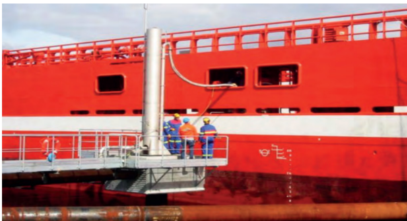
شکل ۴. سوختگیری از طریق خط لوله از مخزن ذخیره‌سازی ترمینال واسطه به کشتی
